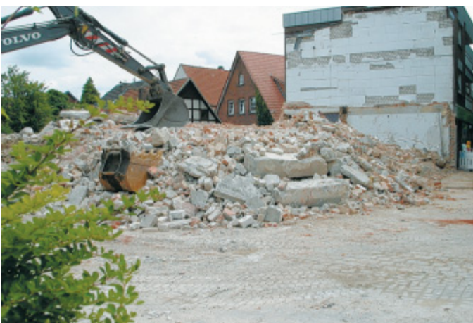
Nurnoch Schutt: Bevor der Neubau in Angriff genommen werden kann, muss noch der Schutt weggeräumt und der darunter liegende Bunker abgetragen werden.
