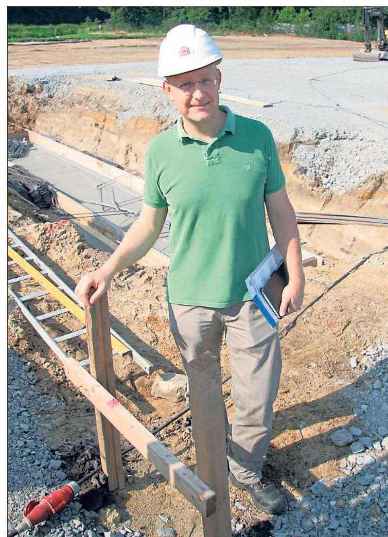
Auf der Bauhof-Baustelle an der Fritz-Wallmeier-Straße: Bauleiter Christoph Blume vom Marienfelder Bauunternehmen Fechtelkord und Eggersmann. Bild: Aundrup
