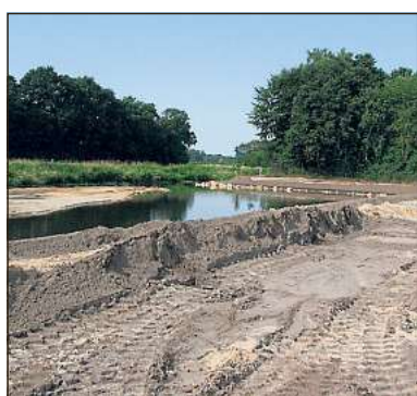
3000 Kubikmeter Boden wurden für die naturnahe Gestaltung des Bachs herausgeholt.
