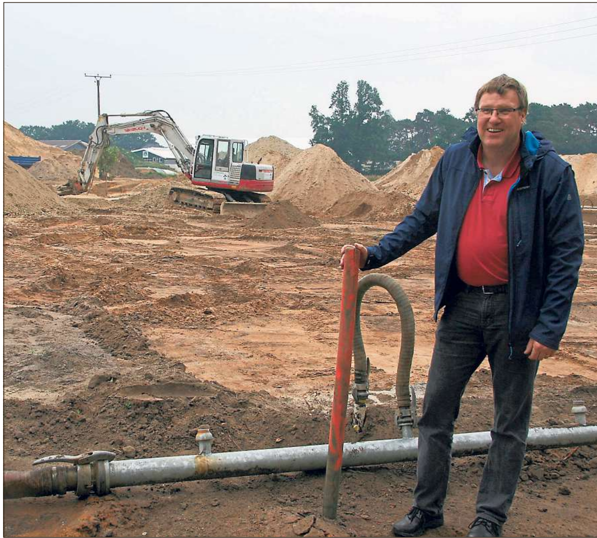
Auf dem Areal, auf dem der neue Bauhof entstehen wird: Bauhofleiter Achim Vorwald zeigt, dass von der bereits ausgekofferten Torflinse nichts mehr zu sehen ist. Bilder: Aundrup
