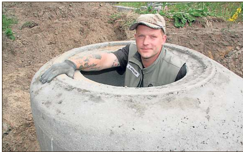
Ist mit dem Aufbau der Kontrollschächte beschäftigt: Daniel Wermeyer vom Tiefbauunternehmen Schnittker hat am Freitagvormittag alle Hände voll zu tun.
