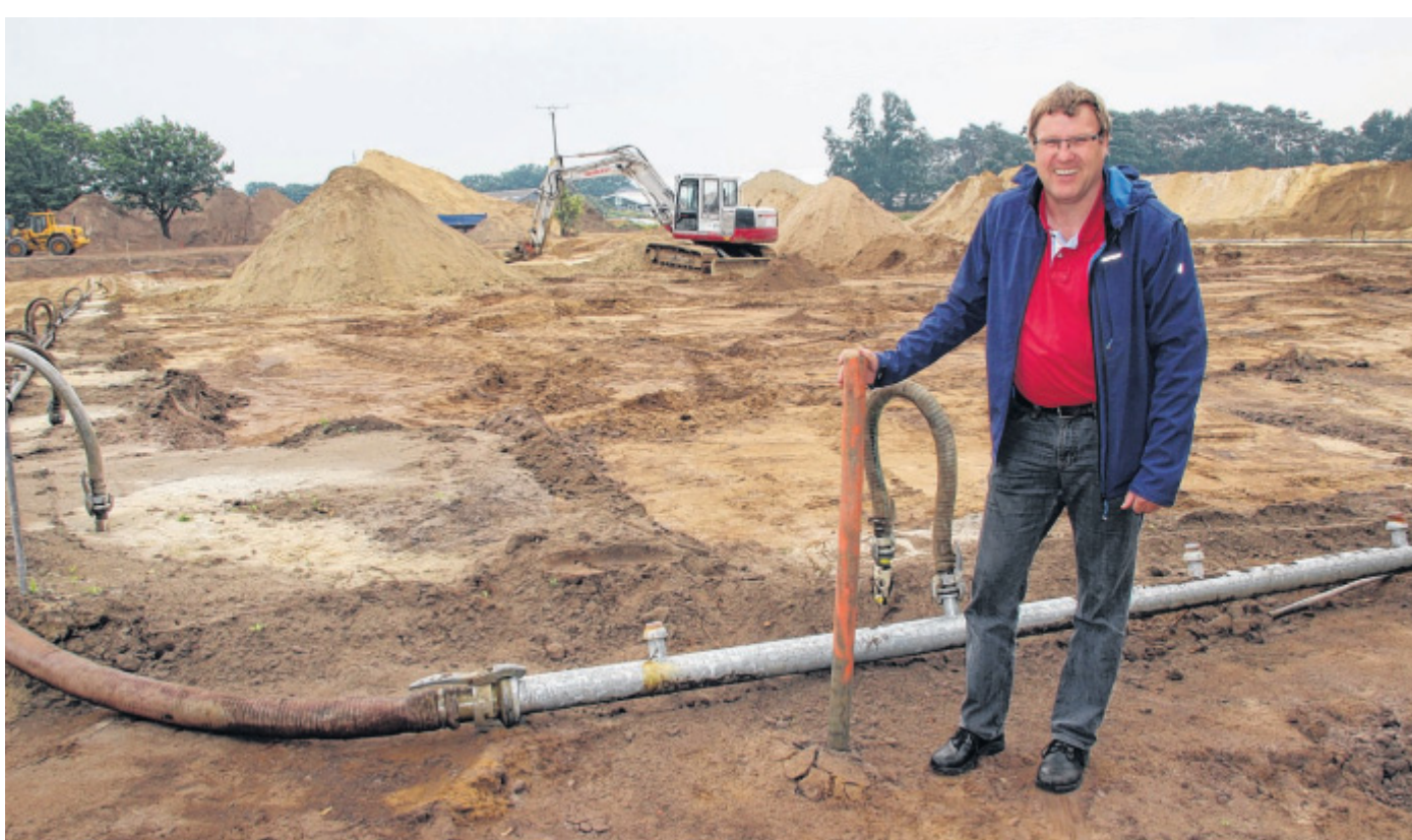
Es geht gut voran: Bauhofsleiter Achim Vorwald machte sich auf der Baustelle an der Fritz-Wallmeier-Straße persönlich ein Bild von dem Fortschritt der Bauarbeiten. Die vorgefundene Torflinse bringt den Zeitplan kaum in Gefahr. FOTOS: RICHARD ZELENKA
